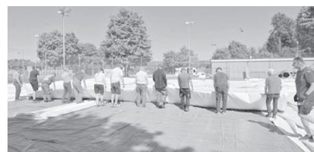
Abbau der Traglufthalle
